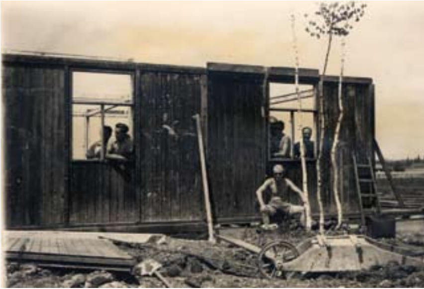
Aufstellung der Werkstatt-Baracke, 1950
