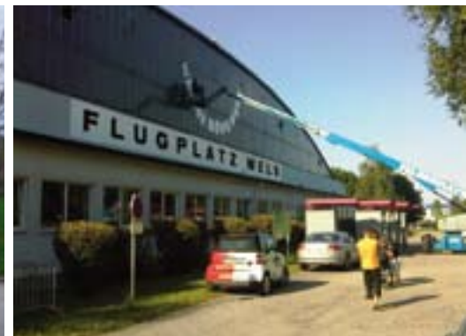
Das Gebäude ist schon neu gemalt und am 7. Juli, kurz vor den Flugtagen, wurde das WMW Logo auf den Hangar montiert
