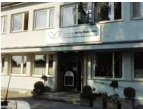
Der Eingangsbereich wurde neu gestaltet: Weg ist die blaue Blechkonstruktion, Holzschalung erneuert und gestrichen, Betontröge neu bepflanzt, und ein neues Schild über dem Eingang
