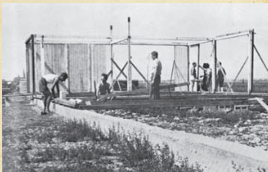
Am Nordostrand des Flugplatzes beginnt die Aufstellung der Werkstatt-Baracke
